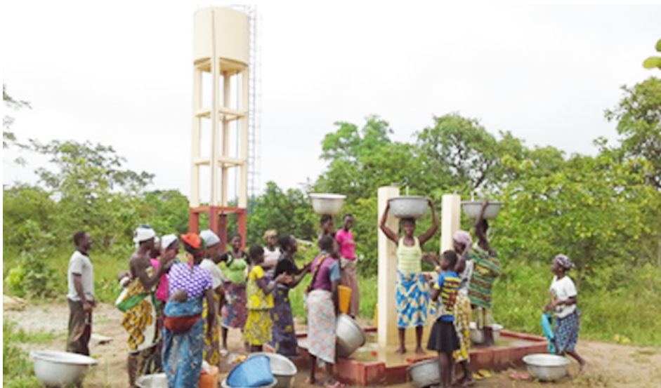
Prise d'eau au niveau du forage TENONROU
